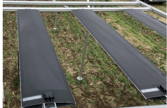
設置完了したペロブスカイト太陽電池
